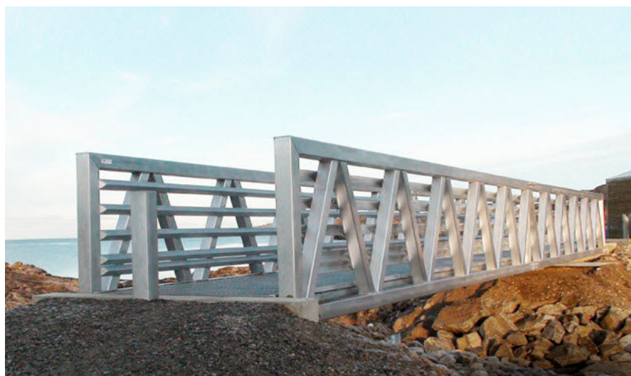
Fotografija 1.2: lagani aluminijski pješački most koji se montira kao cjelina [5]
