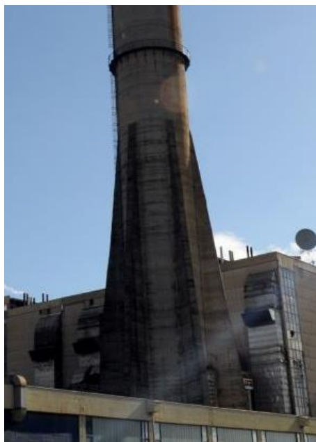
Slika 2.8 Vertikalni trokutasti zidovi kao stabilizatori (TE Sisak) [14]
