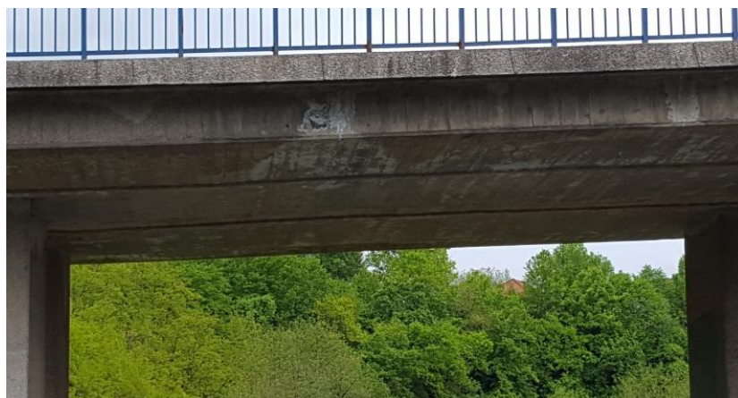
Slika 33. Iscvjetavanje ploče
