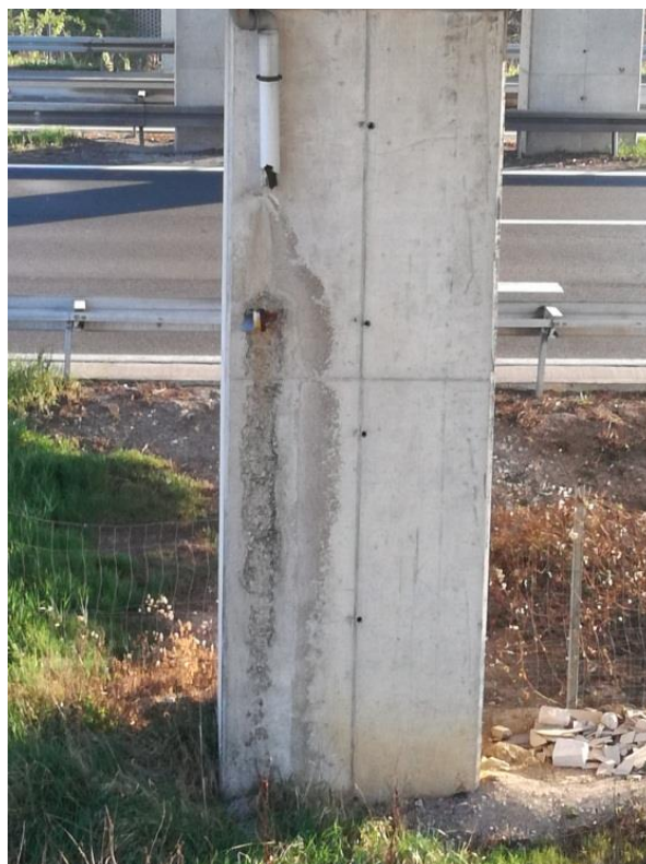
Slika 53. Vlaženje i odlamanje zaštitnog sloja stupa
