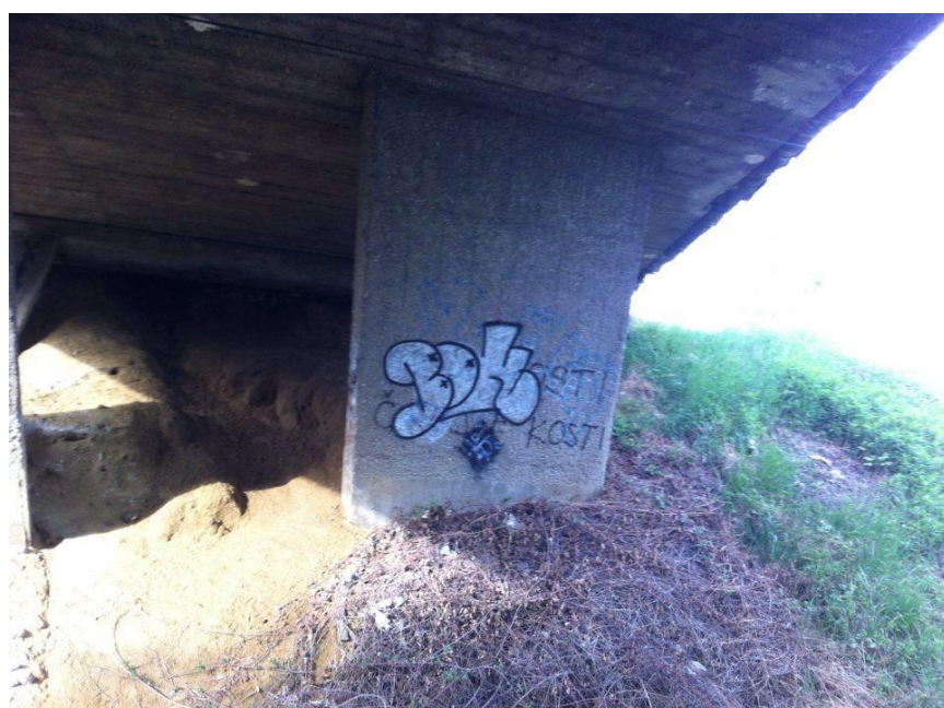
Slika 43.1. Erozija nasipa
