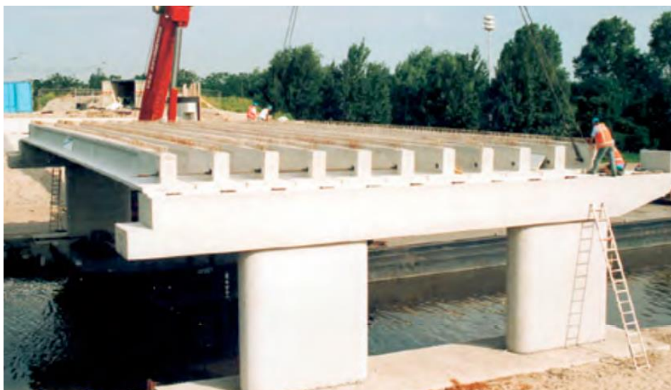
Slika 4. Izvedba mosta sastavljenog od obrnutih T nosača [13]
