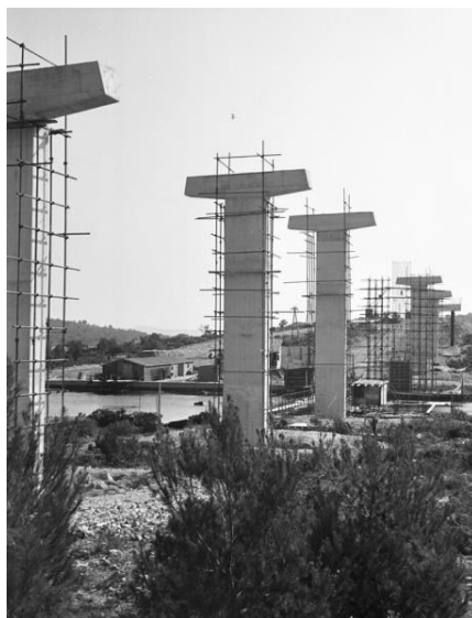
Slika 10.b. Izvedba stupova mosta Ždrelac (foto Seferović, A., 1972.)
