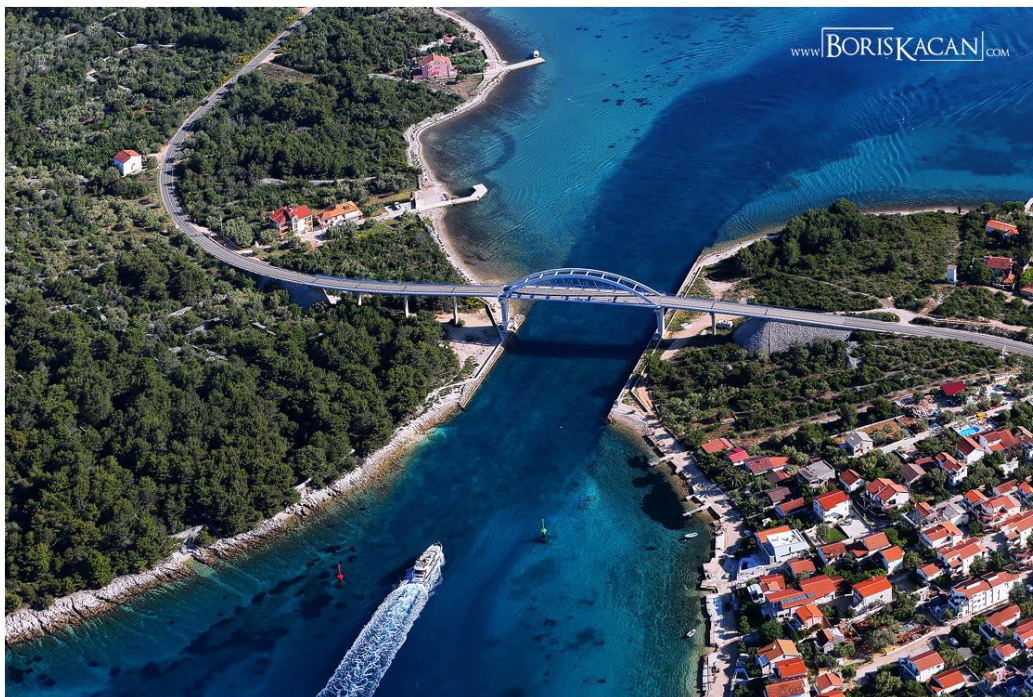
Slika 79. Pogled iz zraka na most Ždrelac danas (foto Kačan, B., 2010.)
