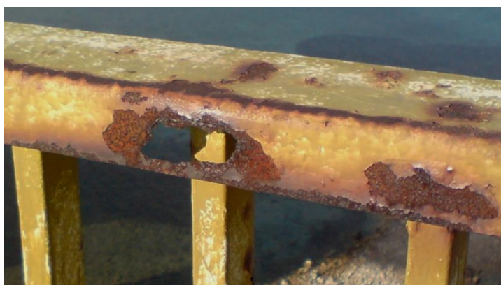
Slika 23. Korozijska ograde (2008.)
