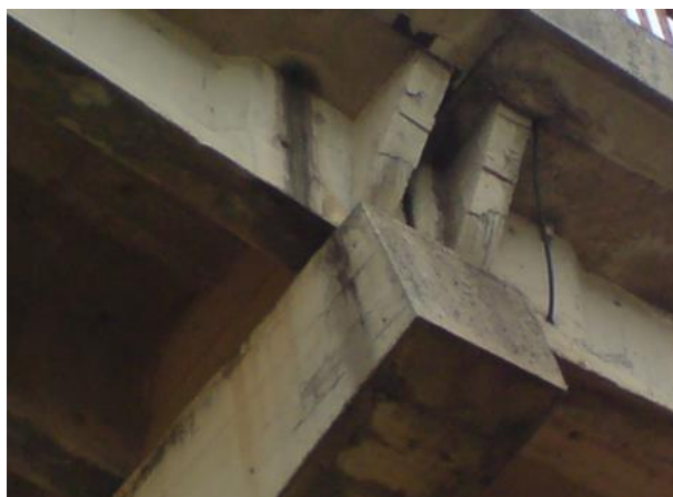
Slika 41. Vlaženje betona (2008.)
