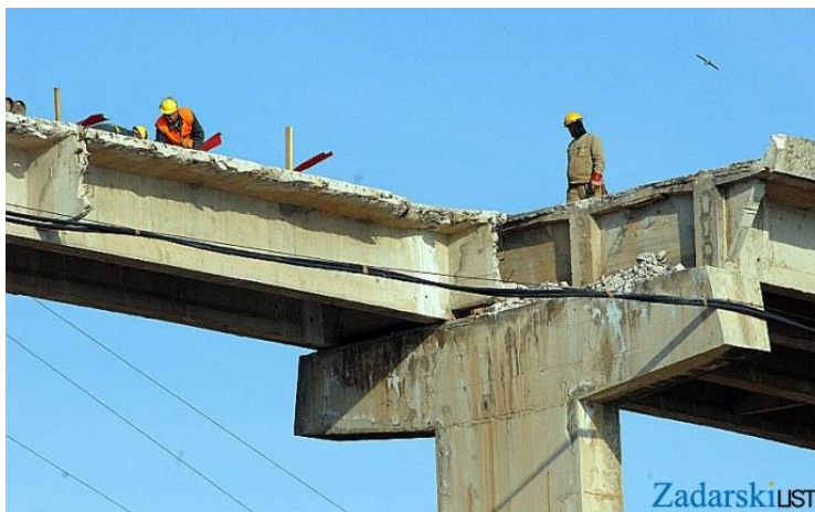
Slika 51. Demontaža preostalih nosača na mostu (foto Zadarski list, 2009.)
