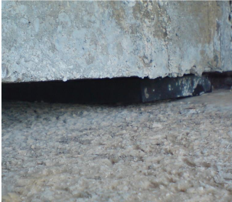
Slika 33. Ležaj na upornjaku U2 (2008.)
