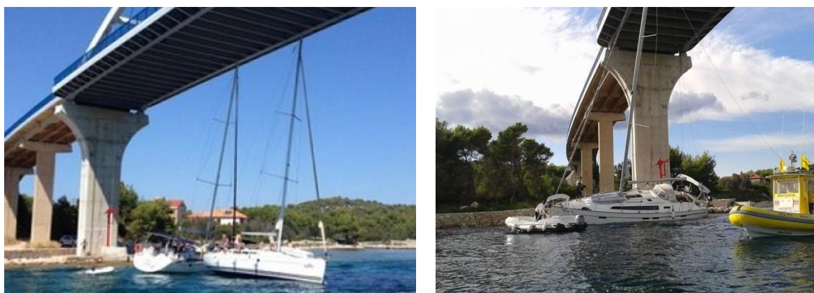
Slika 200. Zapinjanje jarbola jedrilica o rasponsku konstrukciju mosta Ždrelac
