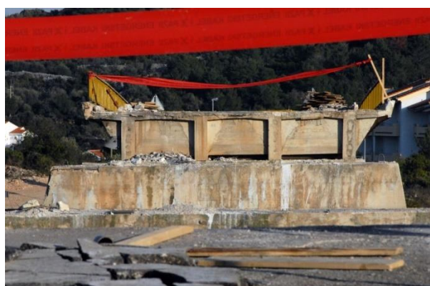
Slika 53. Pogled na demontirane nosače s gornjeg ustroja (foto Zadarski list, 2009.)
