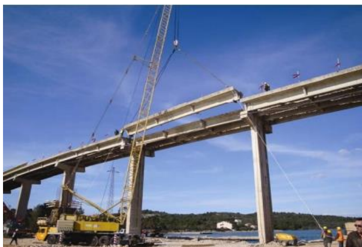
Slika 50. Demontaža prvog nosača na mostu (foto Nadilo, B., 2009.)
