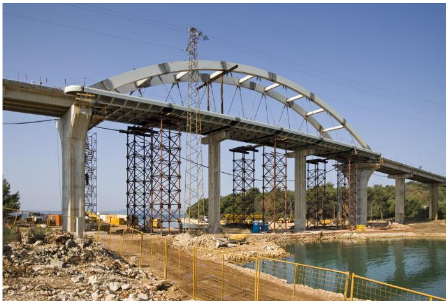
Slika 44. Slika rekonstrukcije mosta Ždrelac (foto Konstruktor - Split, 2009.)
