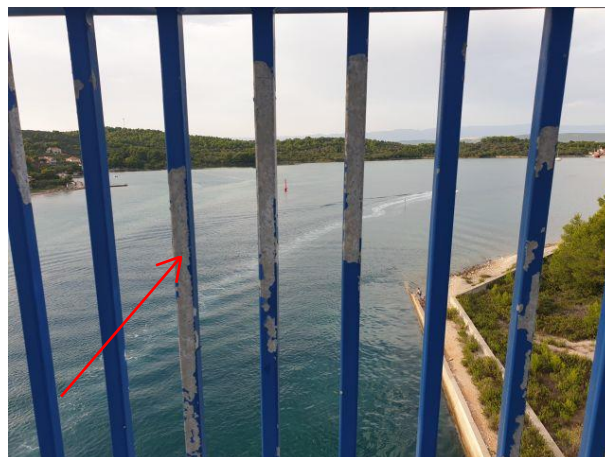
Slika 153. Ljuštenje boje. Stupanj oštećenja S2.
