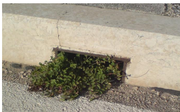
Slika 16. Oštećenje rubnjaka (2008.)
