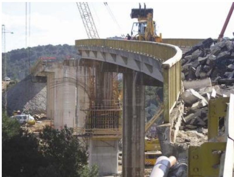
Slika 56. Ojačanje nosivog stupa čelične konstrukcije (foto Nadilo, B., 2009.)
