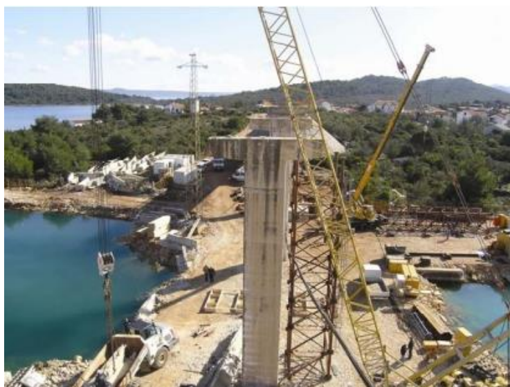
Slika 74. Pogled na gradilište s vrha AB dijela mosta (foto Nadilo, B.,2009.)
