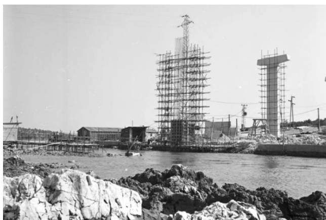
Slika 10.a. Izvedba stupova mosta Ždrelac (foto Seferović, A., 1972.)
