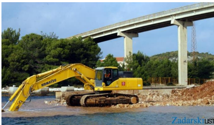
Slika 62. Iskop u plovnom kanalu (foto Zadarski list, 2009.)
