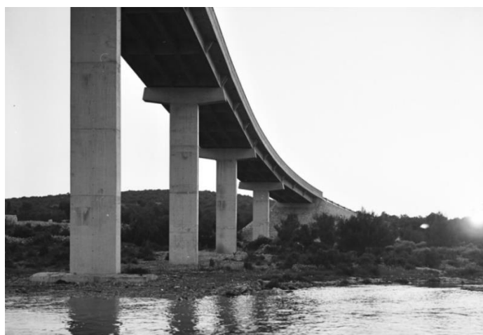
Slika 11. Pogled na donji ustroj mosta Ždrelac (foto Seferović, A., 1972.)
