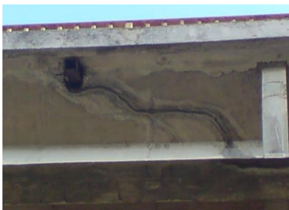
Slika 42. Vlaženje betona (2008.)
