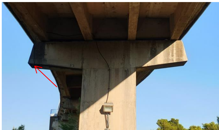
Slika 180. Pokidani strujni kablovi. Stupanj oštećenja S5.
