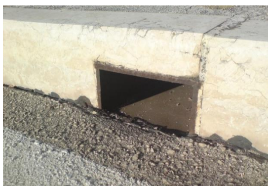
Slika 15. Spoj asfalta i rubnjaka (2008.)
