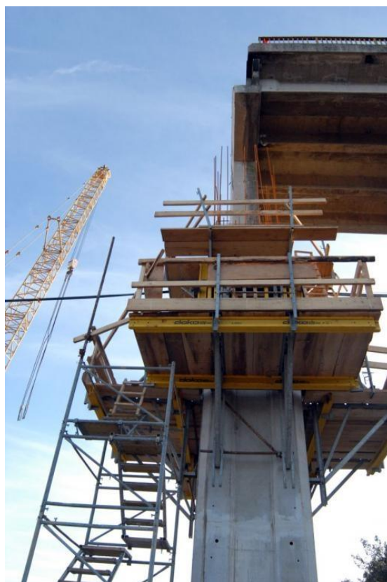
Slika 55. Ojačanje stupa pomoću penjajuće oplata
