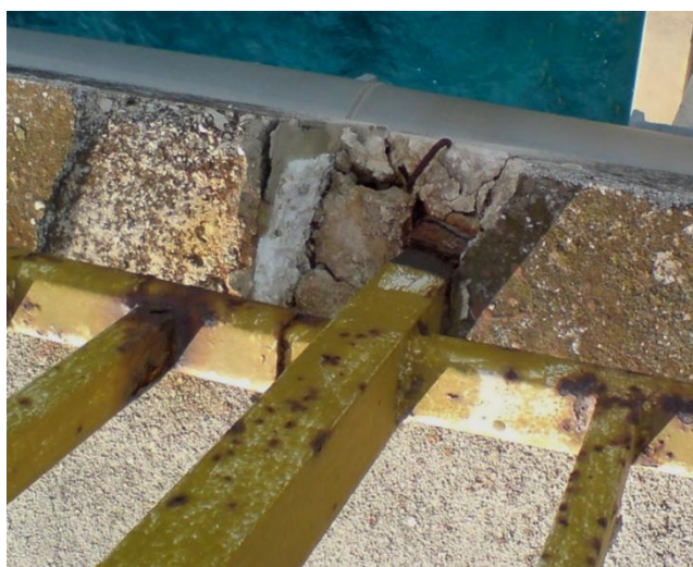
Slika 24. Pričvršćenje ograde u sklop (2008.)
