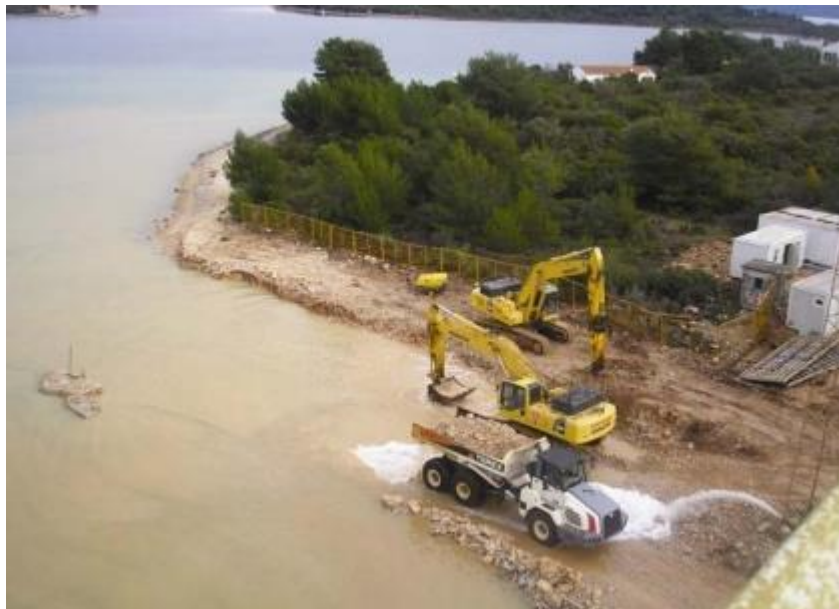
Slika 61. Iskop i proširenje postojećeg kanala (foto Građevinar, 2009.)
