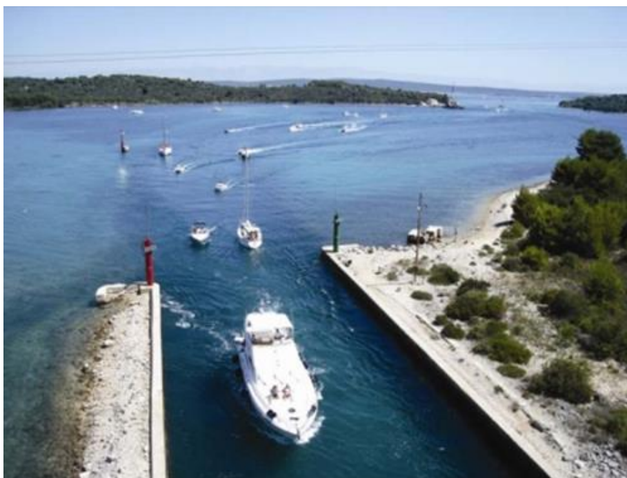
Slika 12. Kanal mali Ždrelac prije zadnje rekonstrukcije (snimak s mosta, 2009.)
