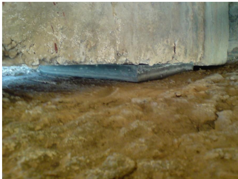
Slika 34. Ležaj na upornjaku U1 (2008.)
