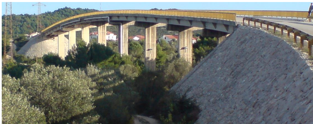
Slika 7. Pogled na most (foto Vidov.V., 2008. )
