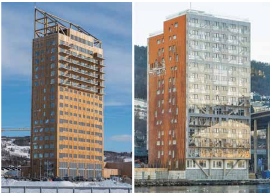
Slika 1. a) zgrada Mjøstårnet, Norveška; b) zgrada Treet, Norveška
