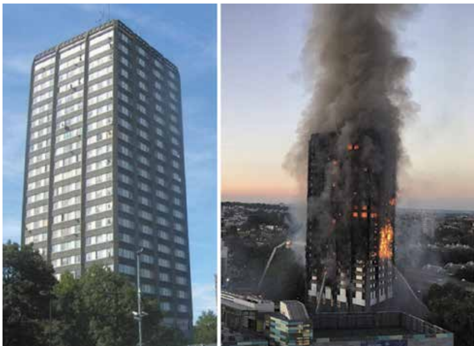
Slika 4. a) Grenfell tower prije renoviranja; b) Prikaz požara u zgradi
