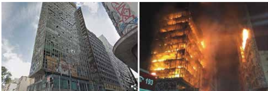
Slika 3. a) Zgrada u Sao Paulu; b) Prikaz požara u zgradi
