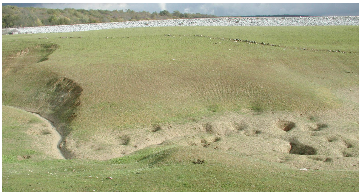
Slika 15. Pogled na ponornu zonu iza brane akumulacije Ponikve. Foto: K. Žganec.
