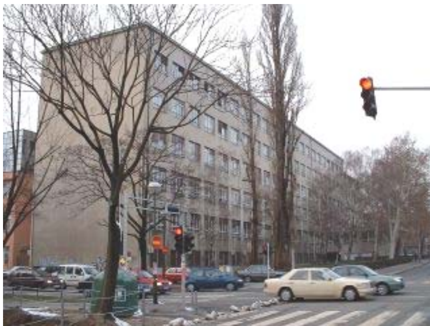
Slika 5.3.7 Fotografija cijele zgrade snimano sa njezine južne strane
