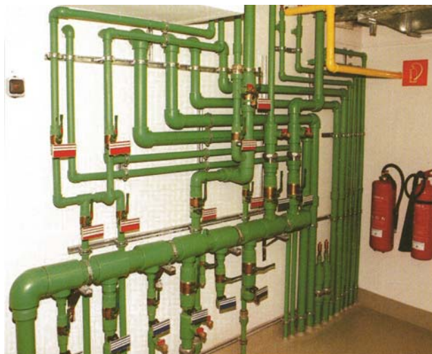
Slika 2. Razdjelnik sanitarne vode od PP-R 80 [1]
