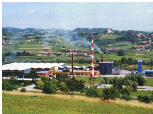
Slika 1. Pogled na tvornicu [2]
