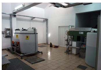
8. Stanica za pripremu i doziranje koagulanata
