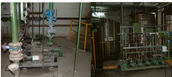
Slika 6. Zatvoreni sustav cjevovoda i pumpi u pripremi veziva [1]
