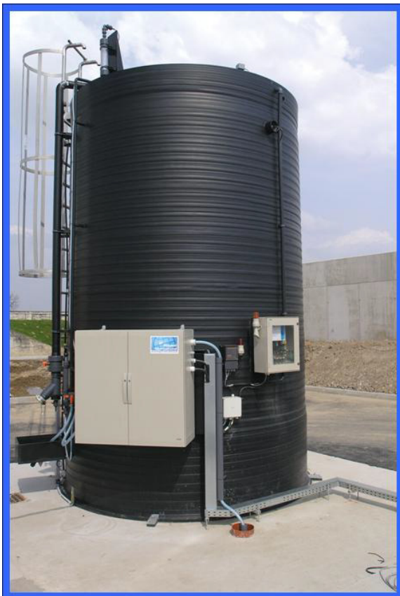
Slika 4. Dozirna jedinica sredstva za uklanjanje fosfora
