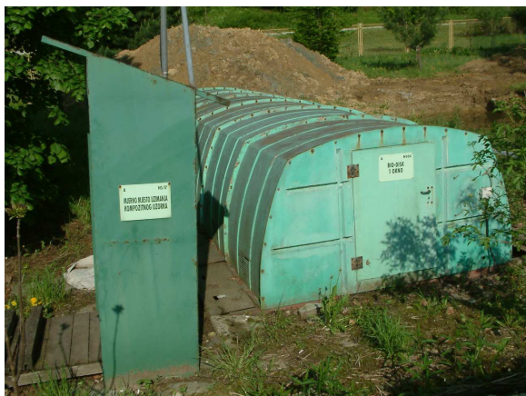
Slika 8. Bio disk i mjerno mjesto uzimanja kompozitnog uzorka
