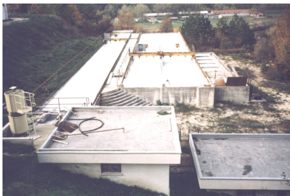
Slika 5a. Prikaz postrojenja za pročišćavanje otpadnih voda u pilani Kamena d.o.o. u Pazinu /taložni bazeni/
