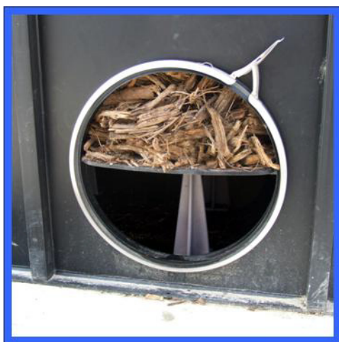
Slika 8. Biofilter za zrak
