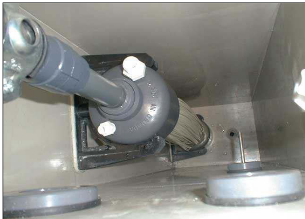
Slika 2. Uronjiva membrana modul ZW 10
