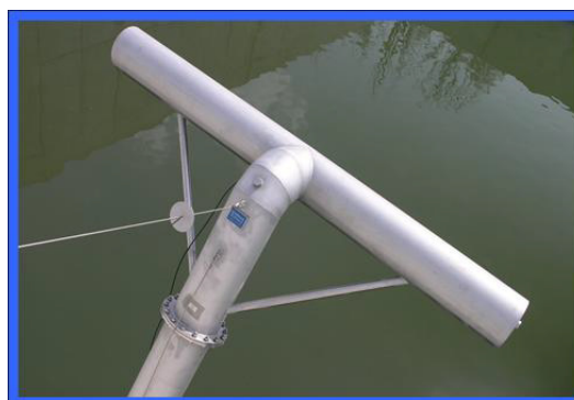
Slika 6. Dekanter SB reaktora
