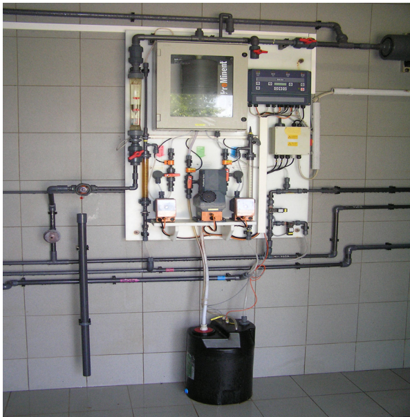
Slika 7. Uređaj za proizvodnju klor-dioksida
