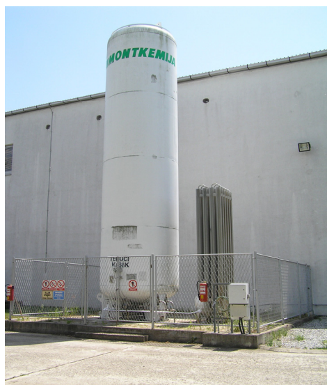
Slika 6. Spremnik ukapljenog kisika s atmosferskim isparivačem
