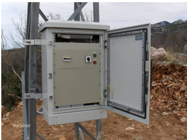
Slika 6. Upravljačka ploča ormara KonDUR 2003
