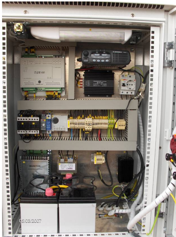
Slika 3. Razmještaj sekundarne opreme u ormaru KonDUR 2003
