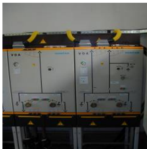
Slika 9. SN sklopni blok tvornički pripremljen za daljinsko vođenje
