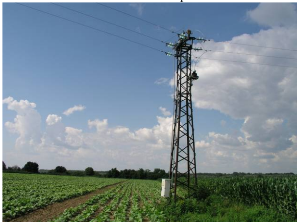
Slika 1. Smještaj opreme na dalekovodnom stupu – Sustav KonDUR 2000
