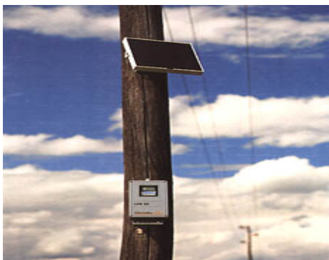
Slika 13. Detektor struje kvara sa dojavom u centar
