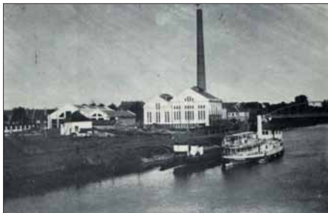
- Pogled na zgrade Munjare i Remize s istoka
