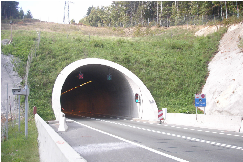
Slika 1. Lijeva cijev tunela Pod Vugleš
