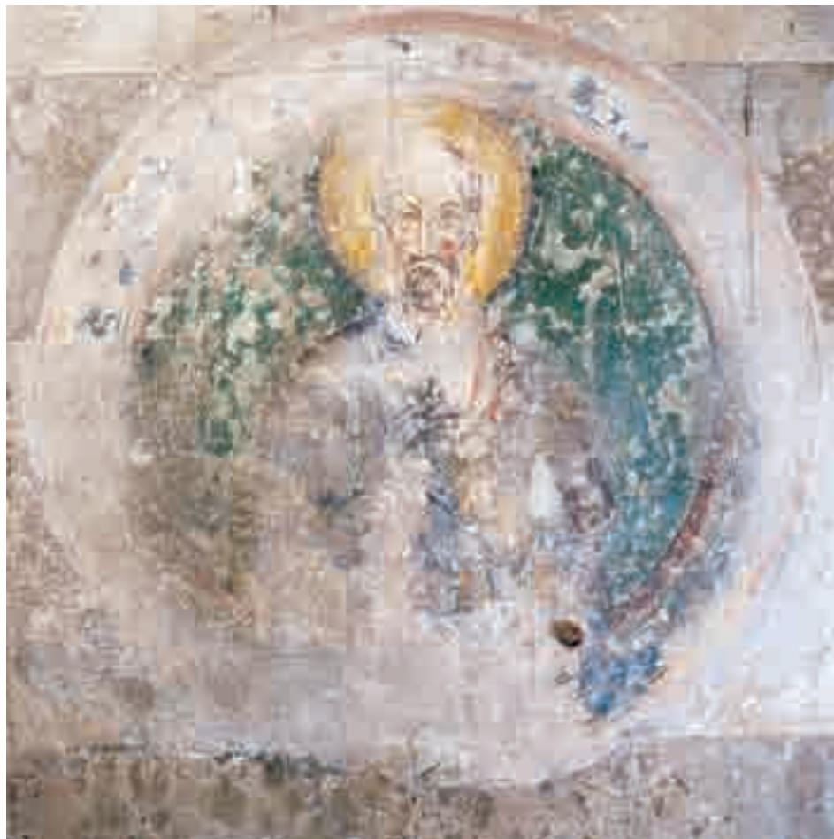
Fig. 45: Medaglione con San Paolo , pittura su pietra, particolare. Zara, cattedrale, facciata interna
