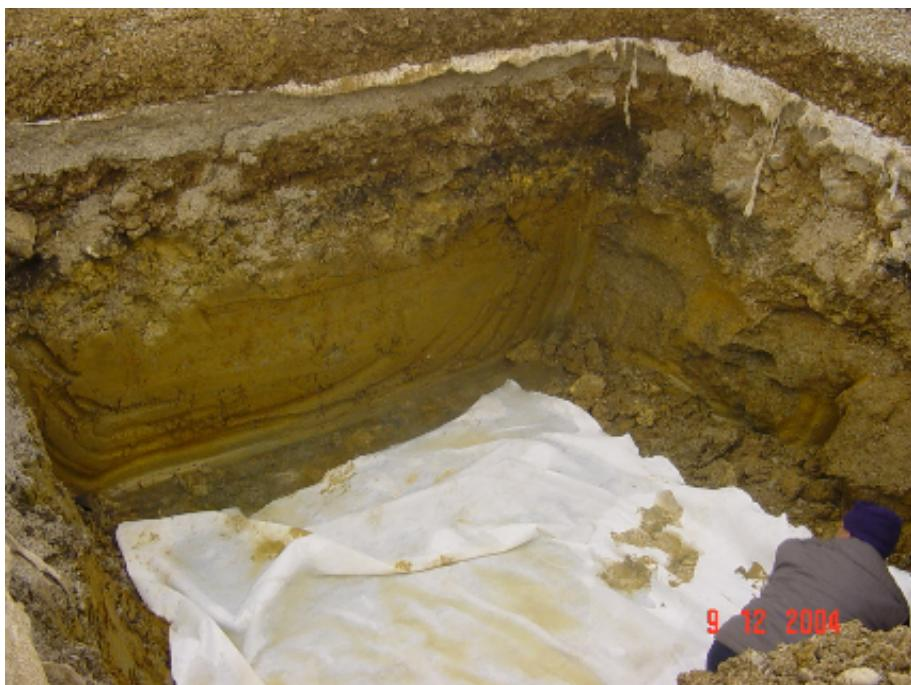
Slika 8. Ojačanje ("armiranje") temeljnog tla geotekstilom (300gr.)
