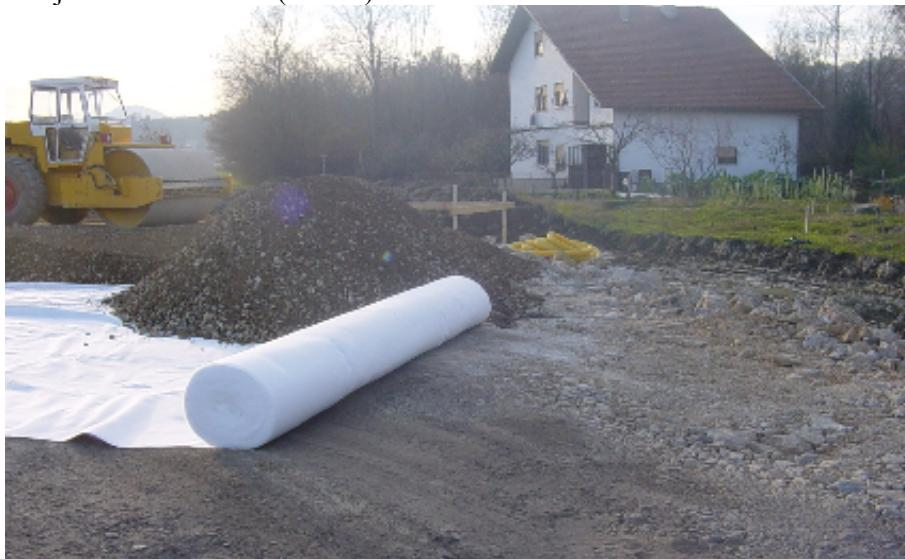
Slika 5. Izvedba radnog platoa nasipavanjem drobljencem i "armiranje" geotekstilom
