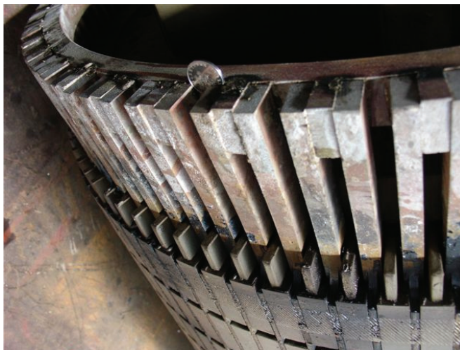
Slika E.1. Oštećenje spoja štapova i prstena
