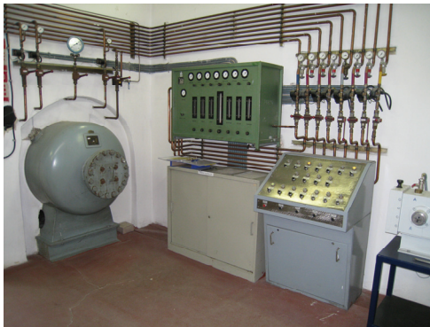
Slika H.1. Miješalica za namješavanje eksplozivne smjese LUDEWIG & TILLMAN
