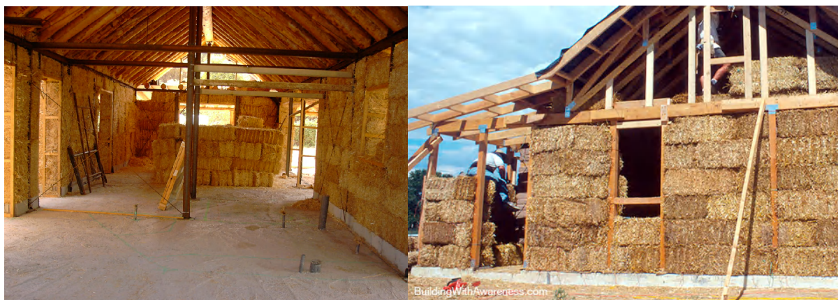
Slika 1. a) i b) Prikaz gradnje baliranom slamom
