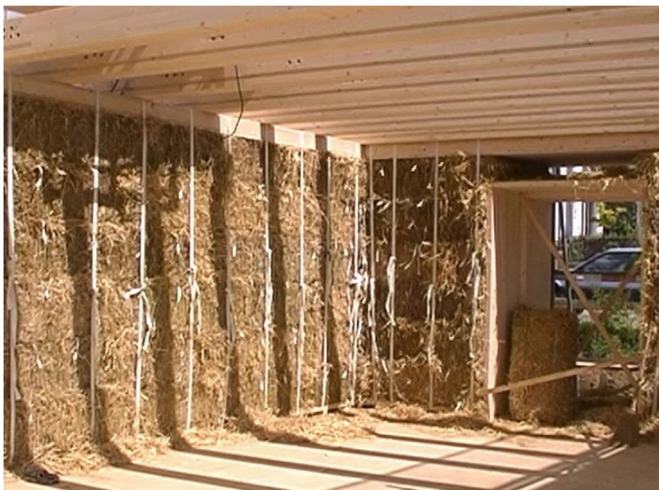
Slika 5. Slama kao nosivi zid i termoizolacijski materijal
