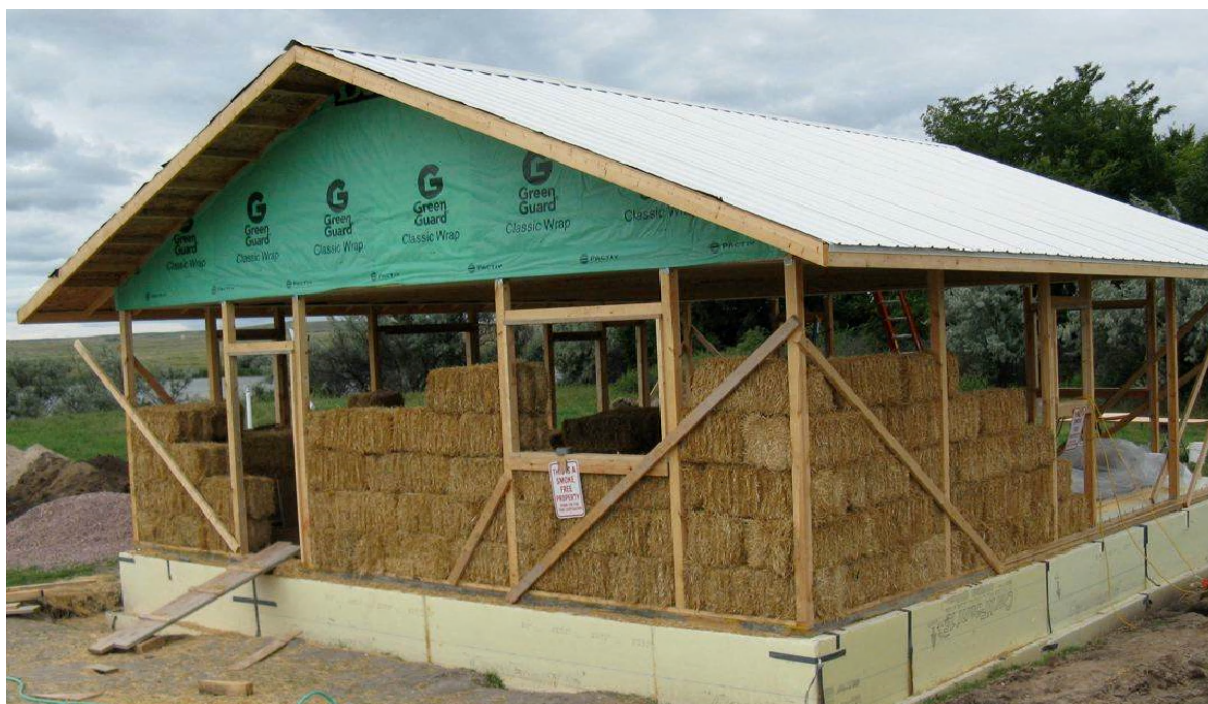
Slika 4. Slama kao termoizolacijska ispuna
