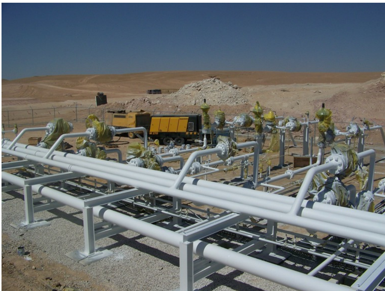
Slika 1.1 Ulazni razdjelnik (Manifold)
