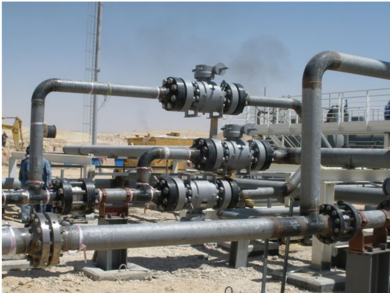
Slika 1.2 Ručni ventili za usmjeravanje toka na ulaznom razdjelniku
