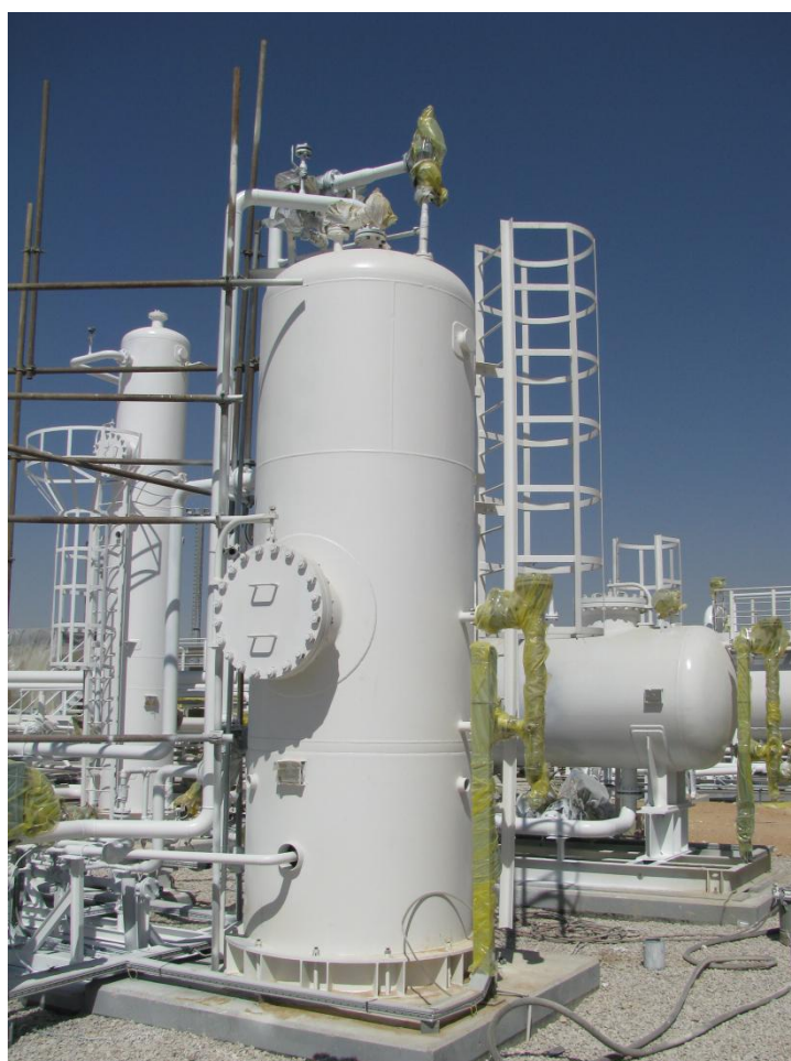
Slika 2.2 Uspravni separator cilindričnog oblika
