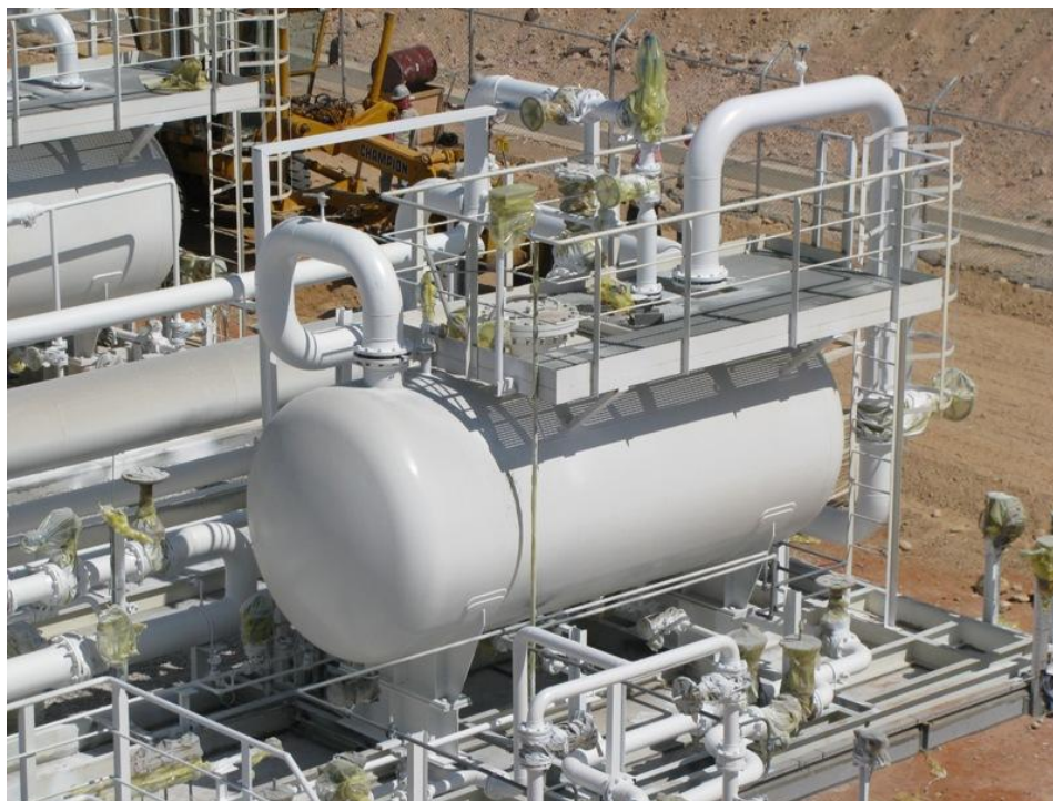
Slika 2.1 Vodoravni separator cilindričnog oblika
