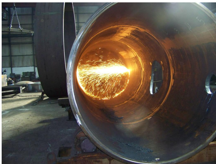
Slika 4.7 Izrada otvora na cilindru visokotlačnog separatora
