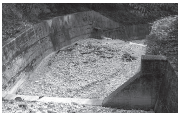
Slika 3 Pregrada za zadržavanje nanosa, bujica Moščenička Draga, stanje - 2011. godina
