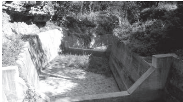
Slika 2. Pregrada za zadržavanje nanosa, bujica Moščenička Draga, stanje- 2004. godina
