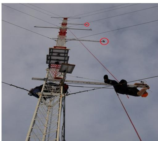
**Slika 4.** Meteorološki toranj postavljen na Pomenom brdu (u blizini Dugopolja). Profesionalni penjač postavlja anemometar na visini od 10 m. Crvenim kružićima naznačeni su već postavljeni anemometri na visinama 20 m i 40 m.
