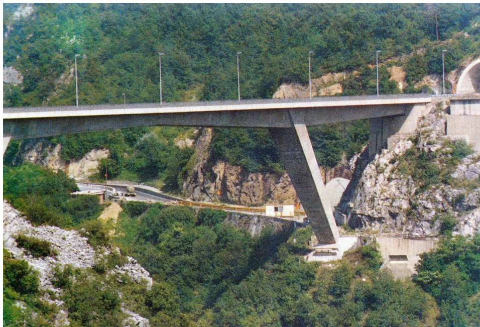
Most Rječina kao dio cestovne obilaznice Rijeke
