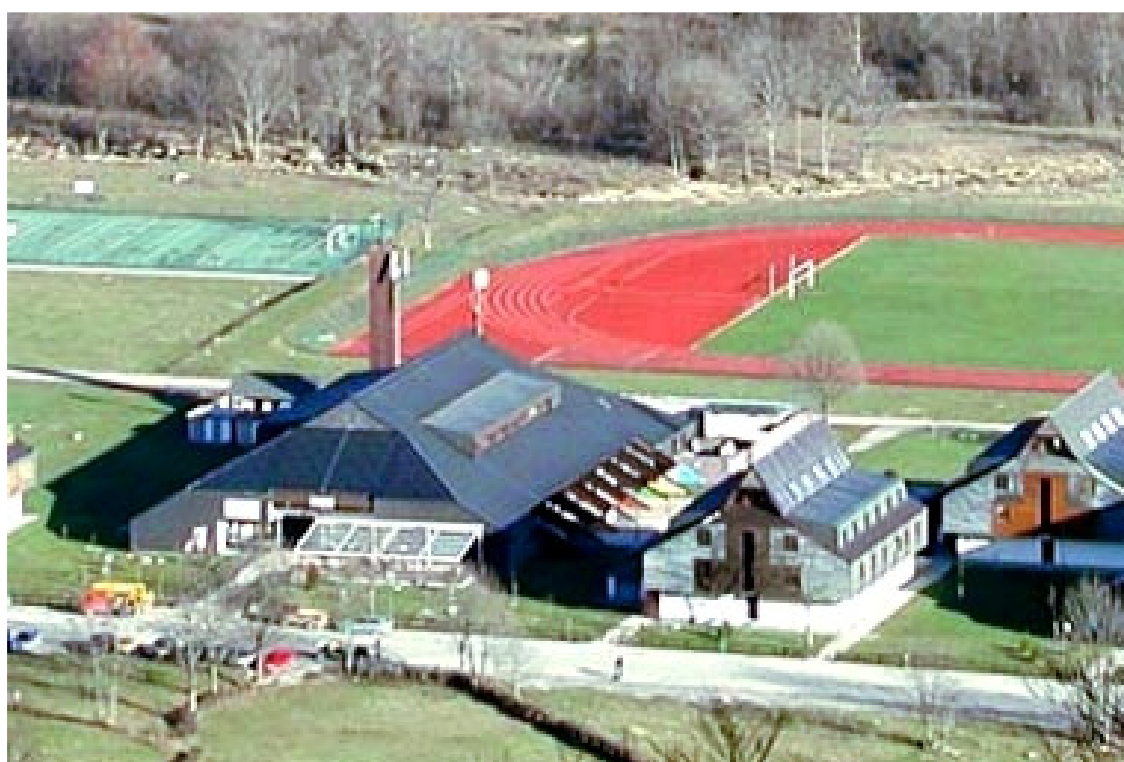
Glavna zgrada u turističkom naselju Bjelolasica
