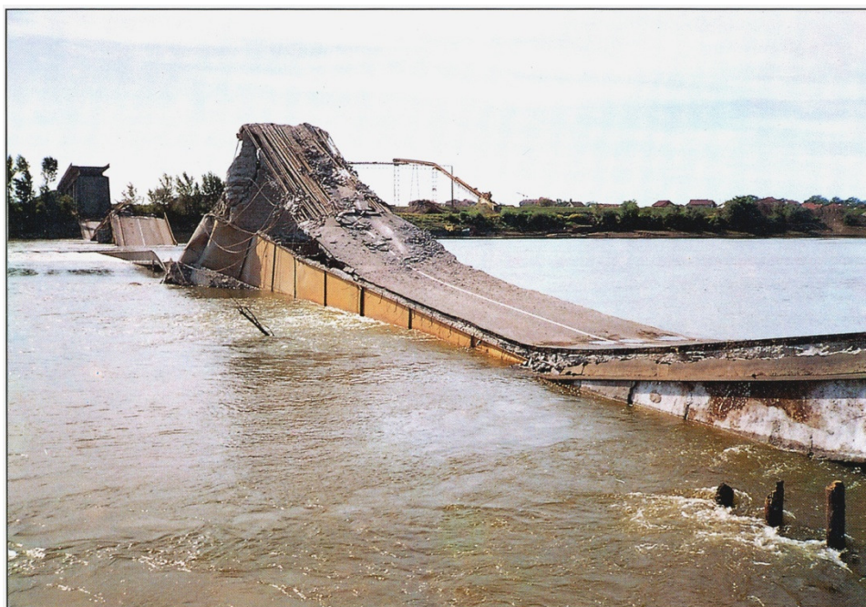
Srušeni most preko Save kod Županje. Mosna konstrukcija onemogućuje i riječni promet na plovnom putu rijeke Save.
