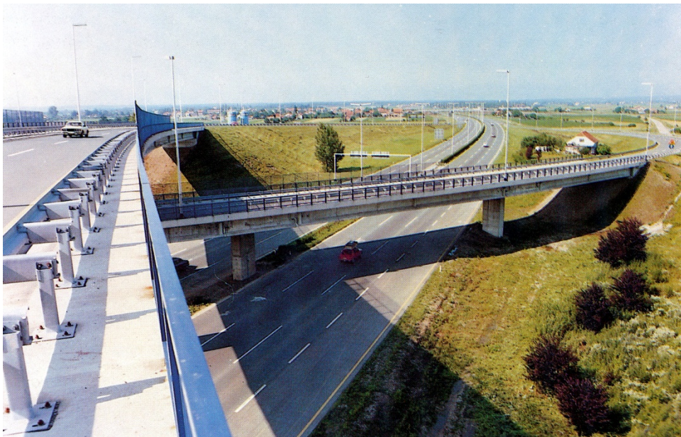
Čvor Lučko na obilaznici Zagreba
