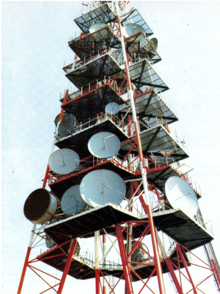
Sustav radiorelejnih antena na Psunju
