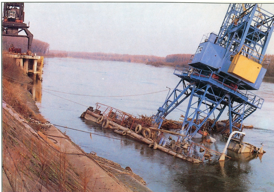
Uništena plovna dizalica u osječkoj luci na Dravi
