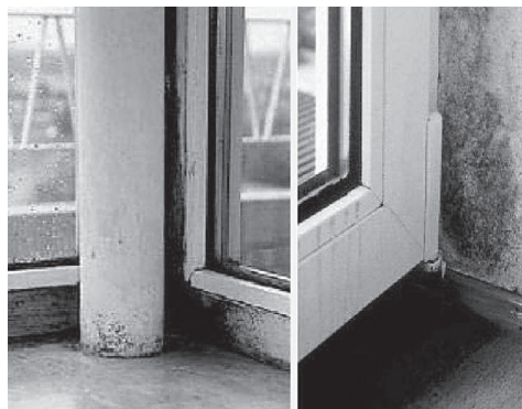
Slika 3. Razvoj gljivica zbog kondenzacije vodene pare oko prozora
