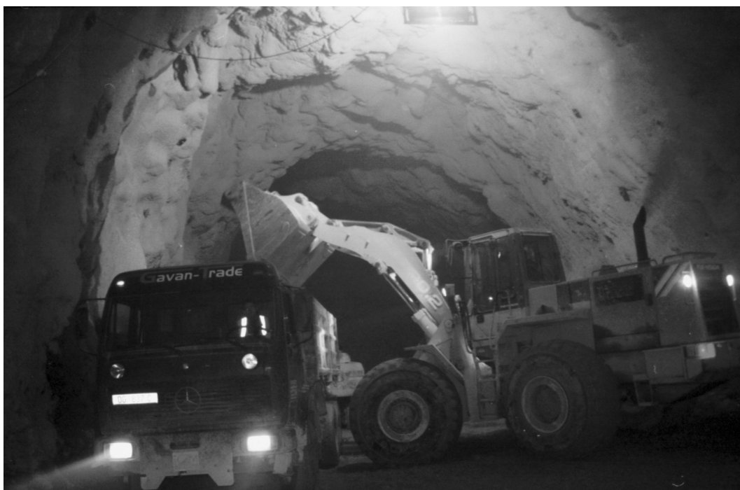
SLIKA 29. UTOVAR STIJENSKE MASE NA TUNELU "MALA KAPELA"
