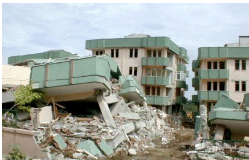
Slika.1 Potpuni slom armirano-betonske konstrukcije uslijed potresa Marmara, Turska, 17. kolovoz 1999.
