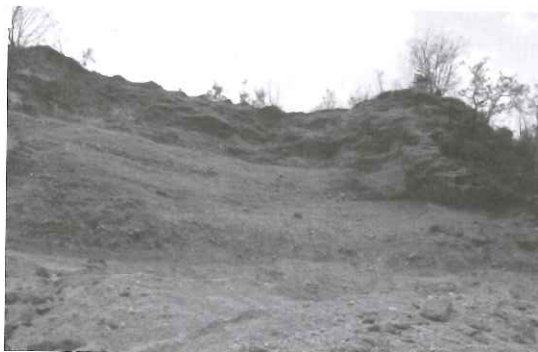
Slika 11. Erodirana površina sipara u slivu bujice Mošćenička Draga
