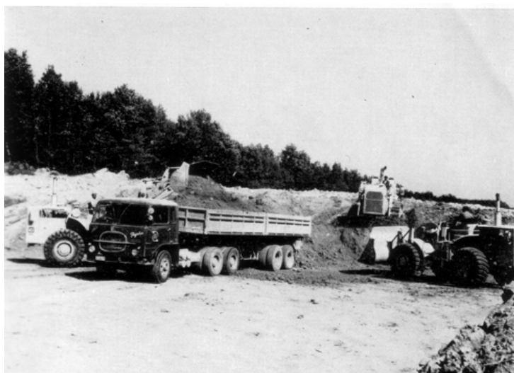
Slika 11.48 Iskop tla na pozajmištu za autocesti Zagreb-Karlovac (Celmić 1974.)
