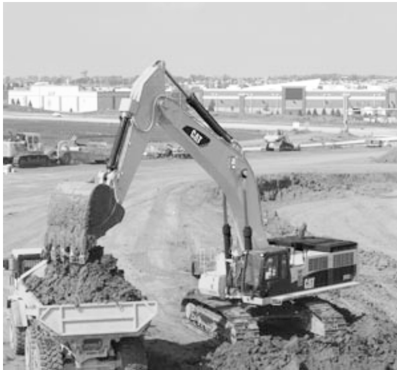
Slika 10.6 Utovar iskopanog tla u kamion jaružalom (bagerom)
