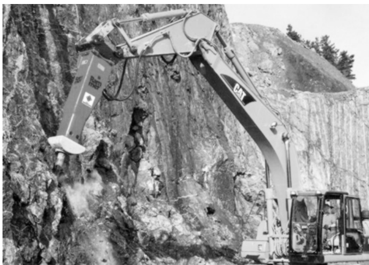
Slika 8.25 Iskop čvrste stijene montaberom
