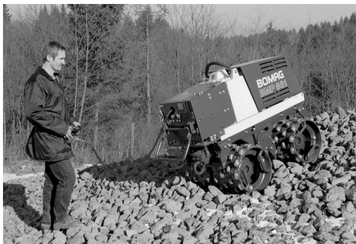
Slika 11.67 Valjak za nabijanje kamenog nasipa
