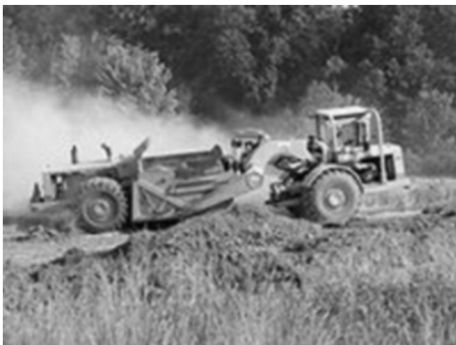
Slika 8.12 Skreper u radu pri iskopu i utovaru
