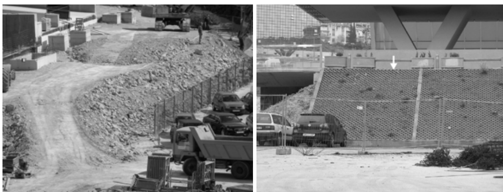
Slika 11.68 Nasip od svježe iskopanog fliša i slijeganje (strelica) istog nakon nekoliko godina (prilaz Sveučilišnoj knjižnici u Splitu, snimio P. Mišćević)
