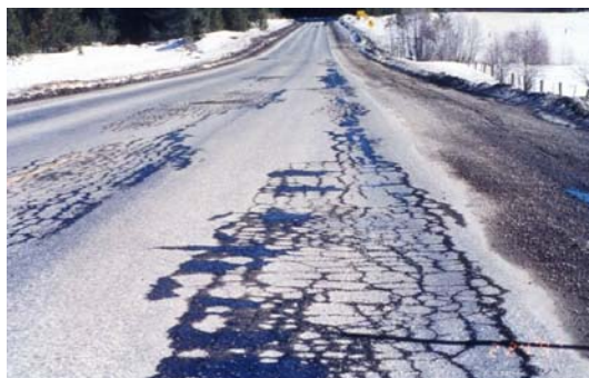
Slika 7.1 Oštećenja kolnika nakon otapanja leća leda
