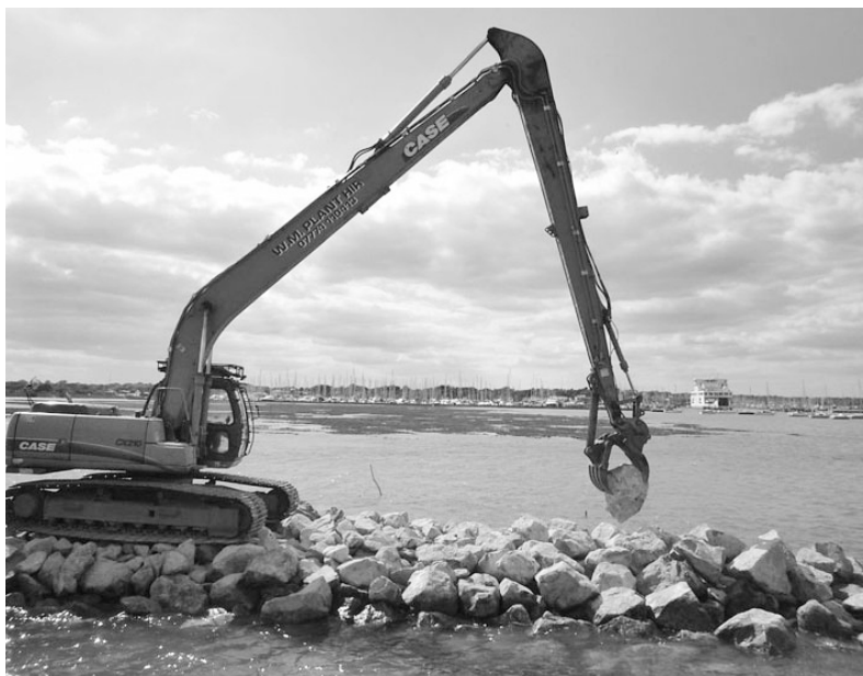
Slika 8.23 Hvatač za polaganje kamena „rip-rap“ na obalu
