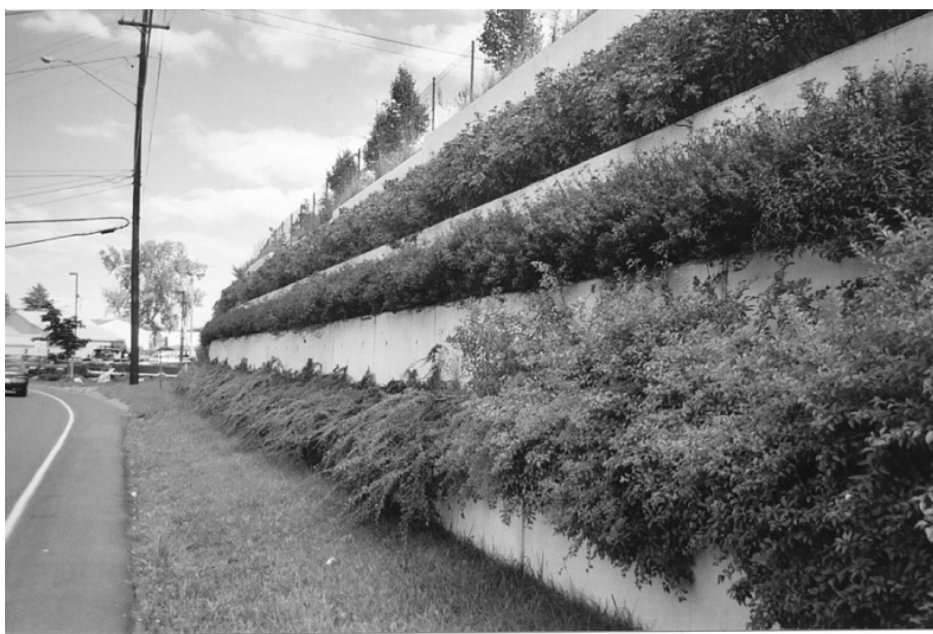
Slika 14.24 Nasip od ojačanog tla s zelenim licem za uređenje okoliša
