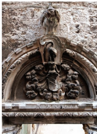
Portal palače D'Augubio
