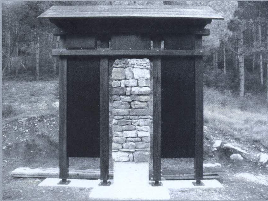
Slika 6. Ugradnja drvene konstrukcije.
