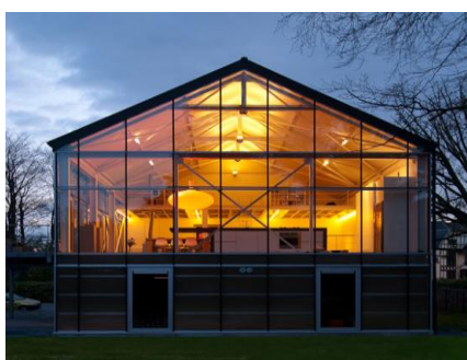
Slika 18a - Obiteljska kuća- Asse, Belgija
