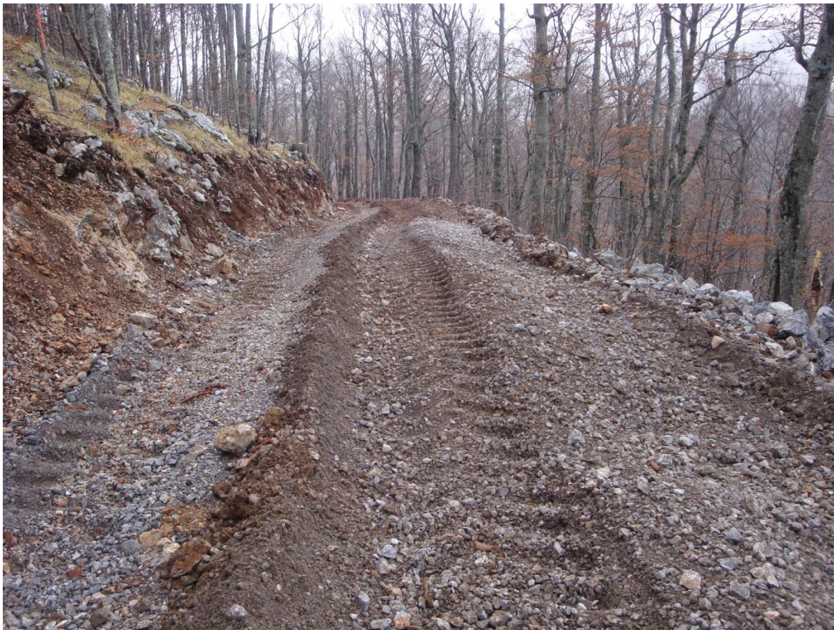
Slika 13. Prikaz šumske ceste i rezultata rada sitnilice za kamen na području Karlobaga (Izvor: Šušnjar i dr. 2009)
