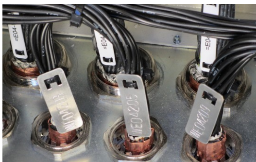
Slika 6. Priključak kabljskog plašta na kućište: koaksijalni priključak i priključak vodičem
