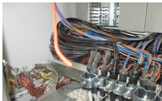
Slika 6. Priključak kabljskog plašta na kućište: koaksijalni priključak i priključak vodičem
