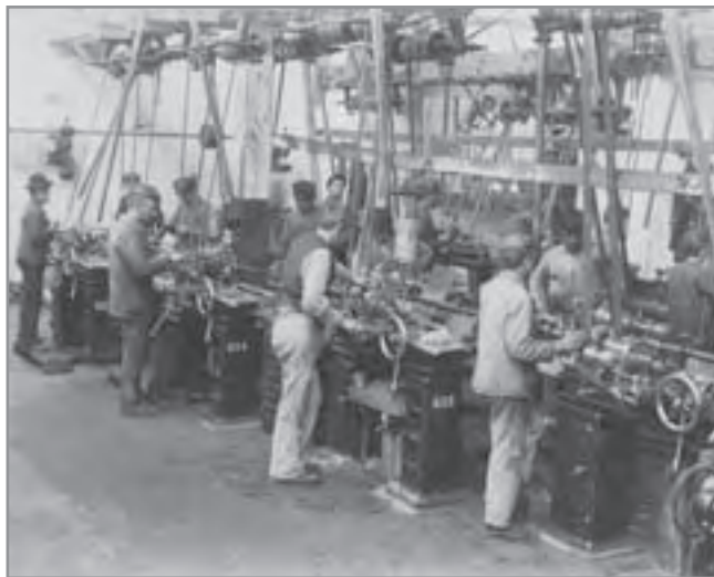
Sl.13. Tokarska radionica krajem 19. stoljeća, jedan od rijetkih prizora s radnicima za strojevima što ih je snimio inženjer Karl Hassenteufel. (Državni arhiv u Rijeci)
