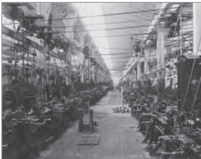
Sl. 14. Pogled na tokarsku radionicu u Whiteheadovoj tvornici oko 1900. Prizor podsjeća na onodobni običaj da središnji parni stroj proizvodi energiju za cijeli pogon. Energija se do pojedinoga radnog mjesta prenosi pomoću sustava osovina, remenica i remena. U prvom planu su osovine za motore torpeda. (Državni arhiv u Rijeci)
