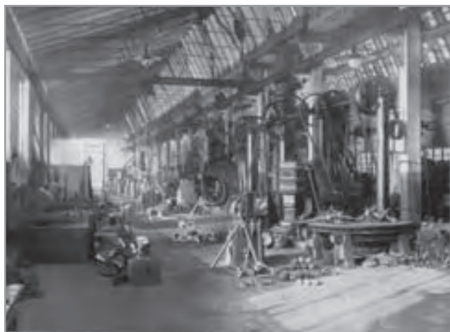
Sl. 22. Pogled na ljevaonicu početkom 20. stoljeća. I plašt torpeda, kao i pojedini dijelovi motora, lijevao se i potom tokario i obrađivao kod kuće, u vlastitim pogonima. (Società di Studi Fiumani – Archivio Museo Storico di Fiume, Rim)
