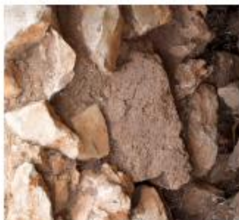
Sl. 22. Sjeverni zid vježbališta s kontraforom.
