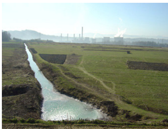
Slika 10. Ispuštanje vode za transport pepela u Tuzli. Velike čestice i opterećenje solima u akumulaciji velikih naslaga i taloga duž kanala otpadne vode. (fotografije: W Fitz).
