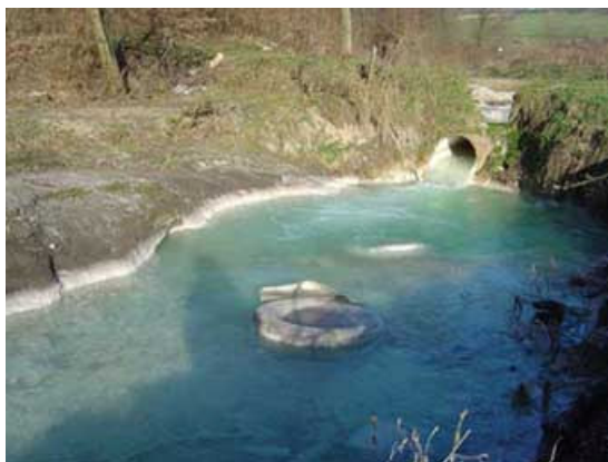
Slika 10. Ispuštanje vode za transport pepela u Tuzli. Velike čestice i opterećenje solima u akumulaciji velikih naslaga i taloga duž kanala otpadne vode. (fotografije: W Fitz).
