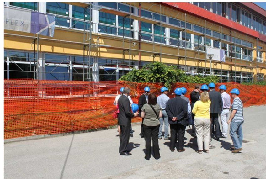
Varaždin, Srednje škole, učenički dom Ukupno 9 zgrada u okviru Programa energetske obnove
