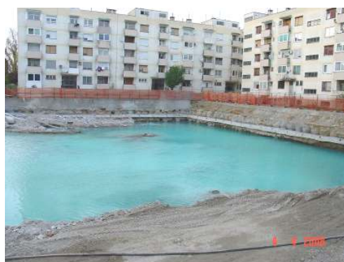
Slika 9 Kontrolirano potapanje jame
