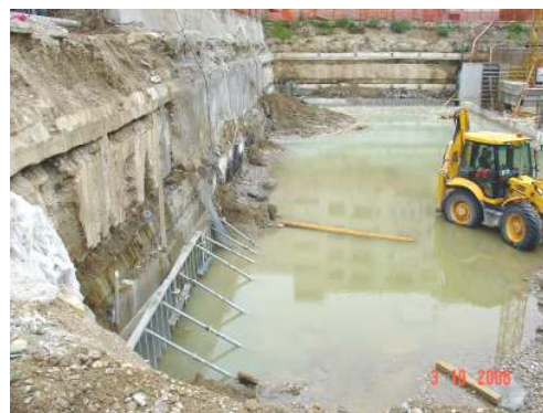
Slika 12 Korištenje mini talpi u svrhu sprečavanja prodora vode i tla
