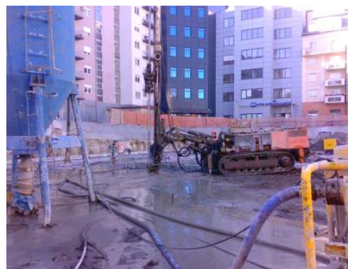
Slika 1 Pogled na građevinsku jamu te neposredna blizina susjednih objekata
