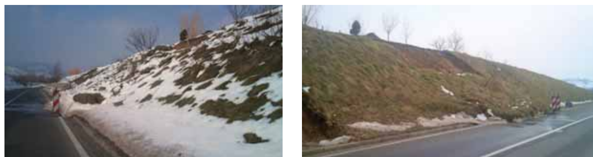
Slika 8 Pokos uz cestu i malo klizište snimljeno pod snijegom 25.01.2013 (lijevo) i, već prošireno, vjerojatno pod utjecajem topljenja snijega, 01.02.2013. (desno) (Cvrtila, 2013).
