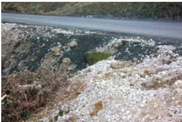
Slika 13 Odlaganje zemljanog materijala i građevinskog otpada uz cestu na kosini (Gorički, 2011) – kao i poravnavanje kosine nasipanjem – najčešće dovodi do klizanja.
