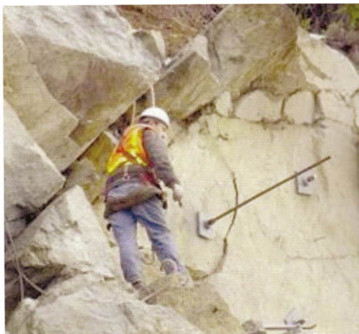
Slika 29 Ugradnja sidara i mreže
