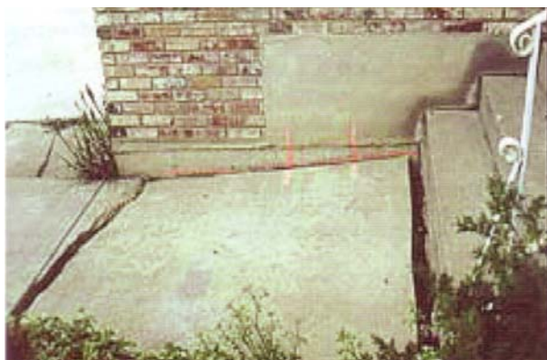
Slika 5 Znakovi klizanja na građevinama
