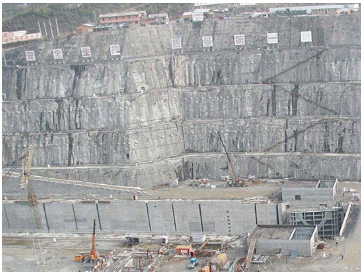
Slika 31 Pogled na usjek brodske prevodnice uz branu Tri klanca u Kini
