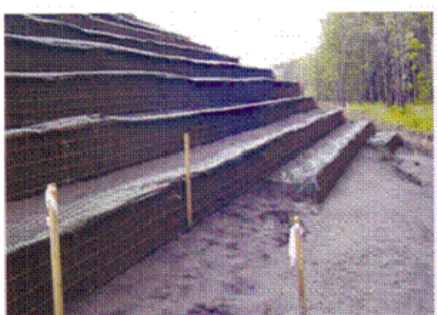
Slika 24 Preventivna zaštita vrha kosine od klizanja
