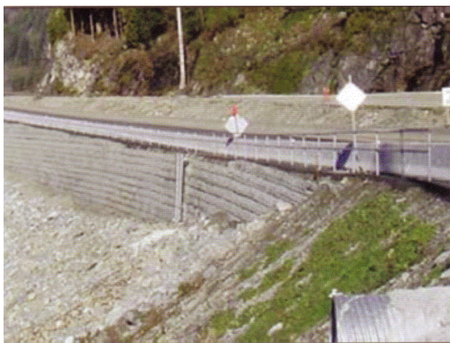
Slika 25 Preventivna zaštita nožice nasipom lomljenog kamena ili šljunka visoke propusnosti
