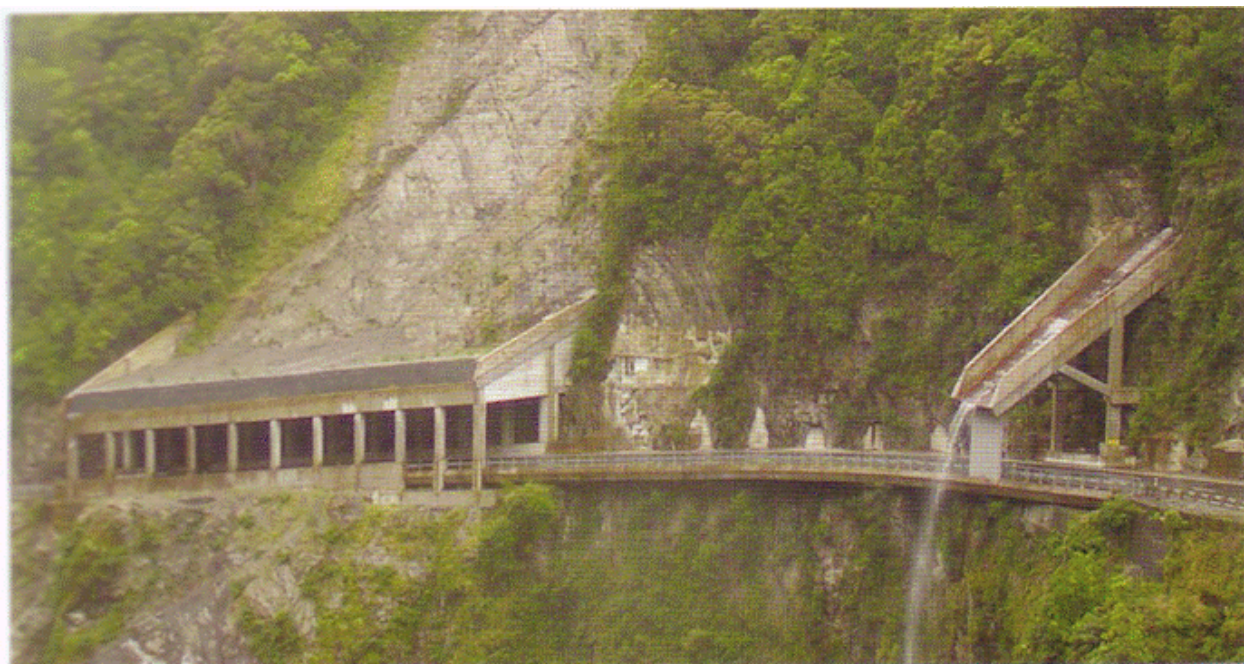
Slika 32 Zaštita prometnice od kamene lavine polutunelom
