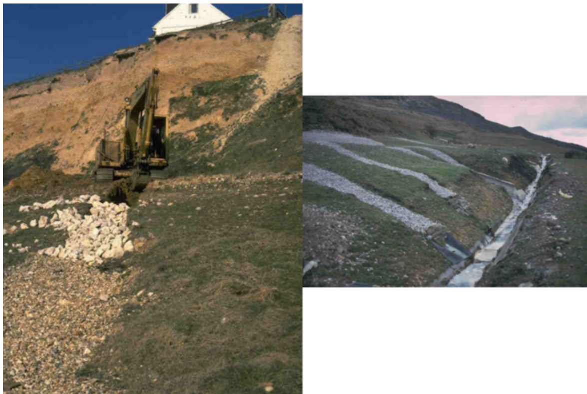
Slika 18 Kopane drenaže
