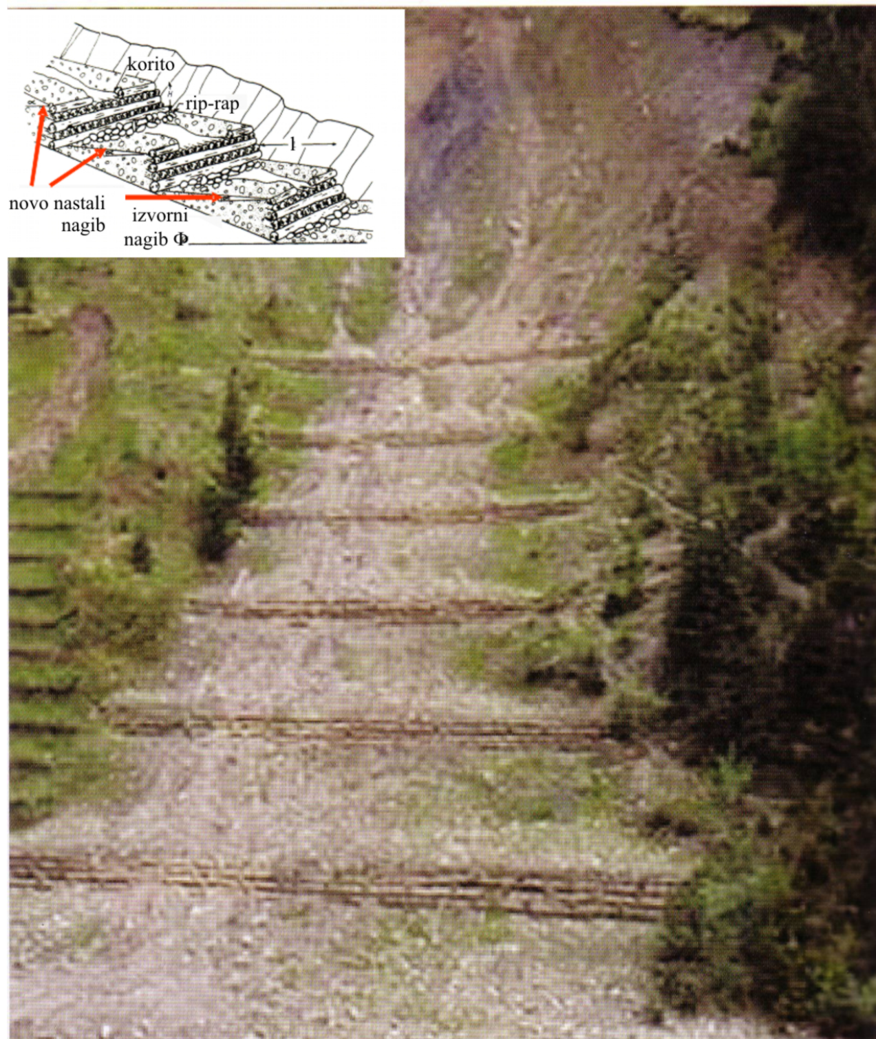
Slika 21 Sanacija korita bujice, potencijalne kamene lavine, pregradama od drvenih trupaca
