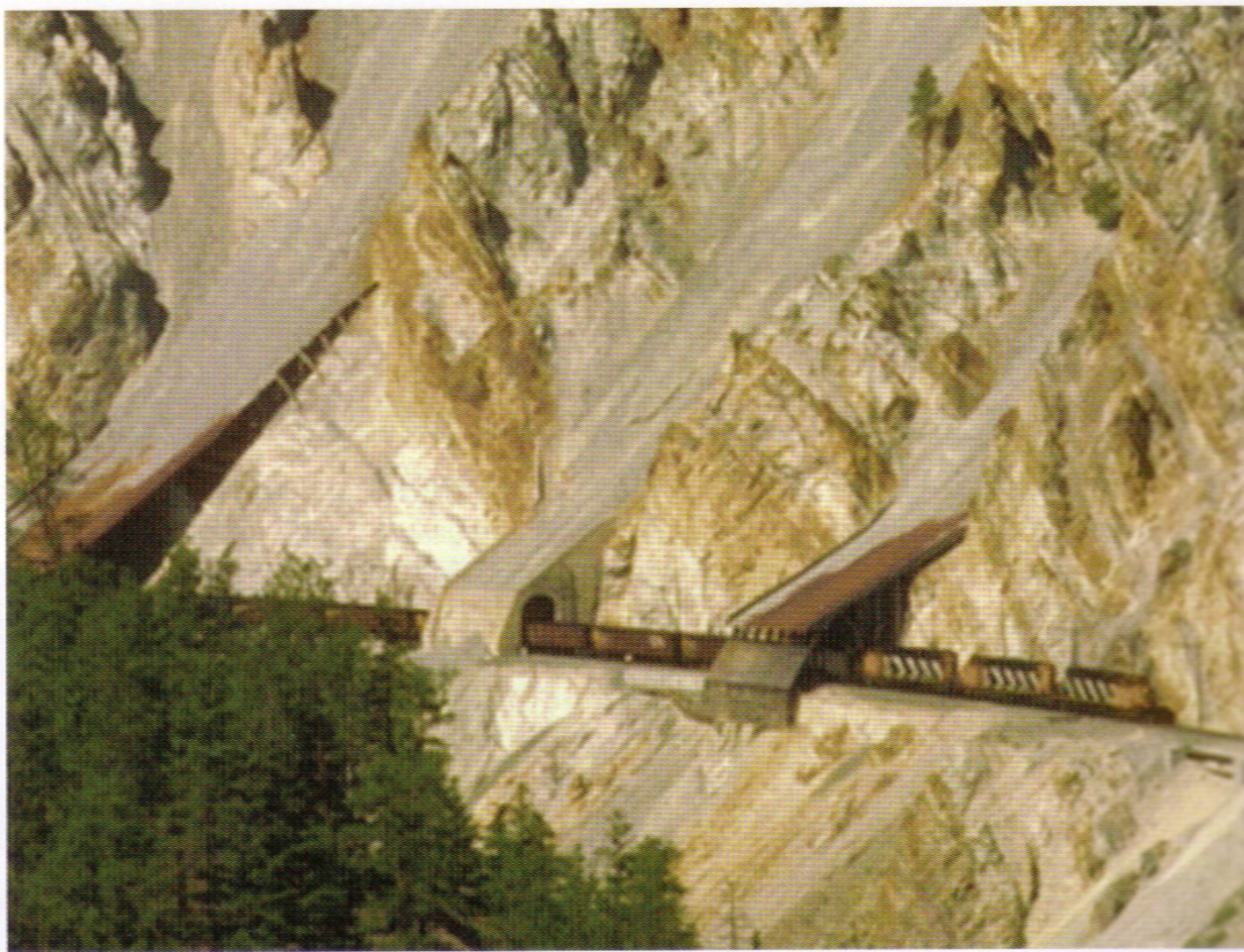
Slika 33 Zaštita željezničke pruge umjetnim tunelima
