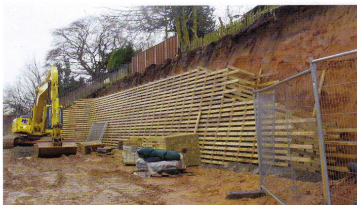
Slika 26 Potporna konstrukcija od drvenih kaveza punjena vodopropusnim gradivom
