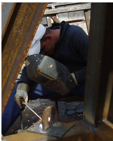
Slika 5.3.1 Ručno elektrolučno zavarivanje
