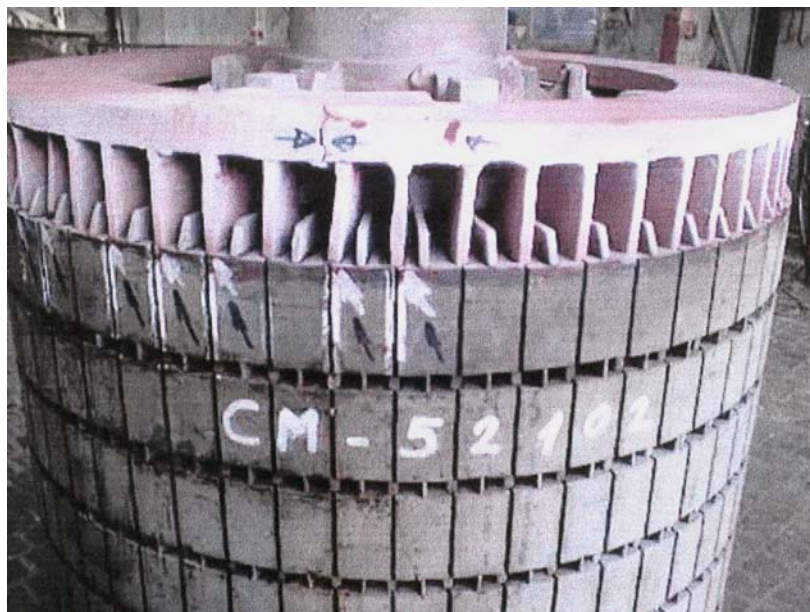
Sl. 4-3 Upotreba penetranta za otkrivanje pukotina u prstenu
