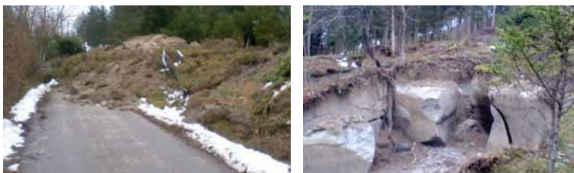
Slika 9 Malo klizište koje je zatvorilo prometnicu u okolici Zaprešića u prosincu 2012. godine jedan je od primjera velike složenosti onoga što se od zemljom nalazi (Perjan, 2012).
