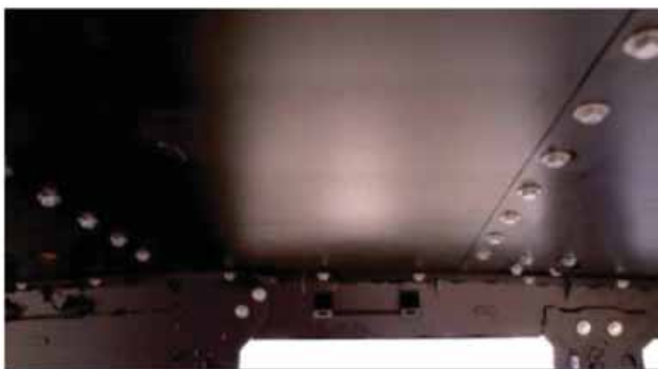
Slika 14. Zaštita krova čeličnim pločama
