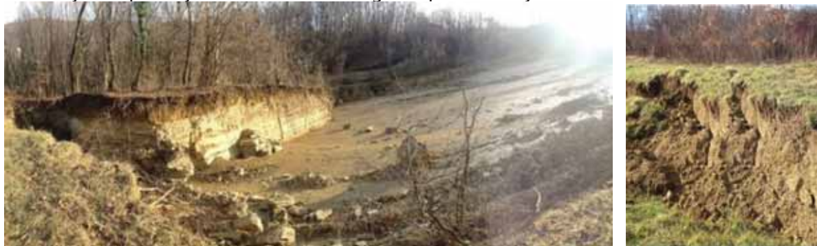
Slika 11 Klizište u Čučerju koje se otvorilo u veljači 2014. godine. Lijeva fotografija pokazuje klizno tijelo i kliznu plohu, desna rub klizišta. (Fabijanić, 2014) Desna fotografija pokazuje nastale pukotine zbog kojih ubrzo slijedi odlamanje blokova tla te razmekšavanje tla zbog oborina koje ulaze u pukotine – jasno je da je širenje klizišta neumitno.
