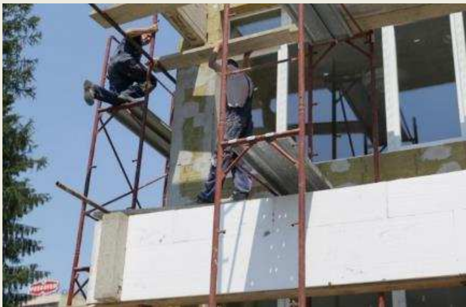
Obnova zgrade Srednje škole u Koprivnici Sufinancira Fond za zaštitu okoliša i energetsku učinkovitost
