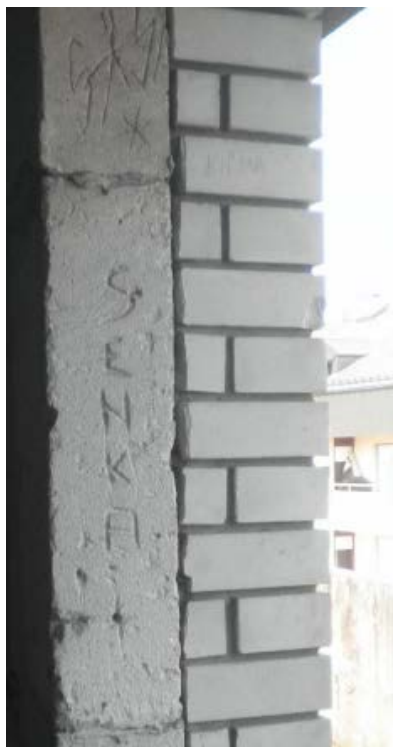
Slika 11. Vanjski zid u potkrovlju
