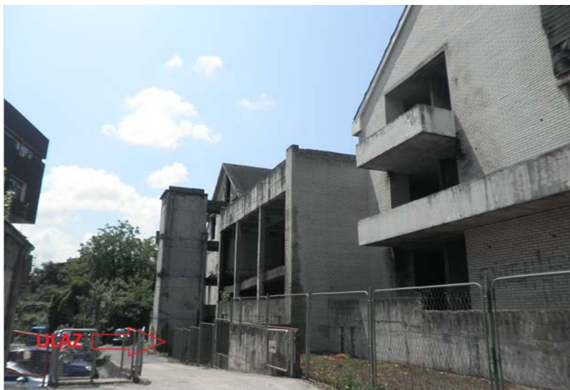
Slika 3. Istočno pročelje zgrade
