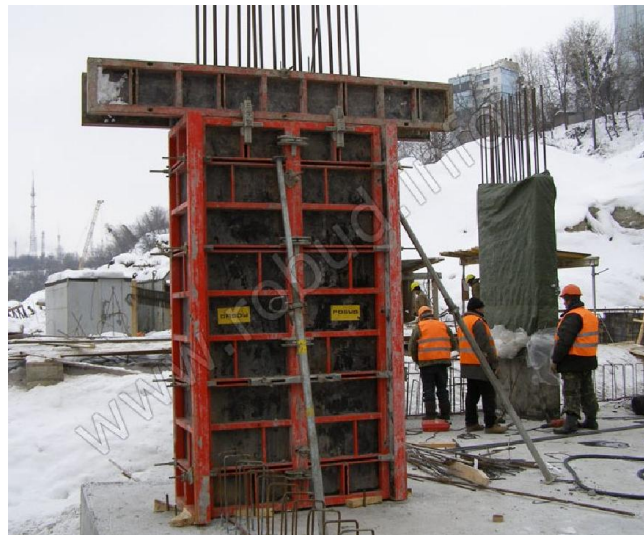
Zagrijavanje betona u oplatama (Ukrajina)
