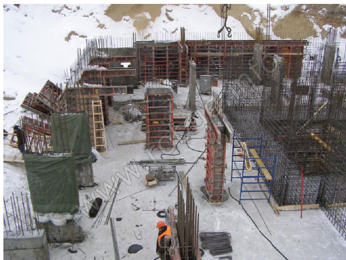
Zagrijavanje betona u oplatama (Ukrajina)
