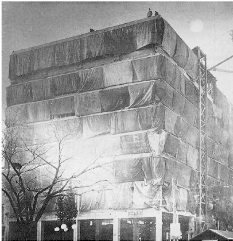
Zaštita od niskih temperatura zraka i hladnog vjetra građevine koja se betonira s izolirajućom termo folijom (cijela zgrada, lijevo) i montažnom konstrukcijom (desno)
