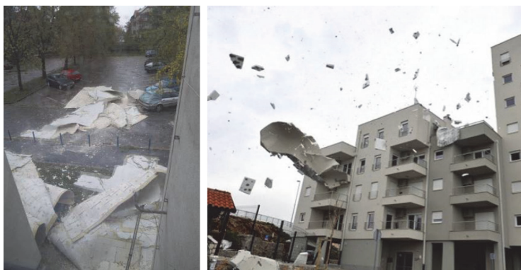
Slika 1. Primjeri rušenja vanjske ovojnice zgrade: a) Zagreb, 2013., b) Rijeka, 2015
