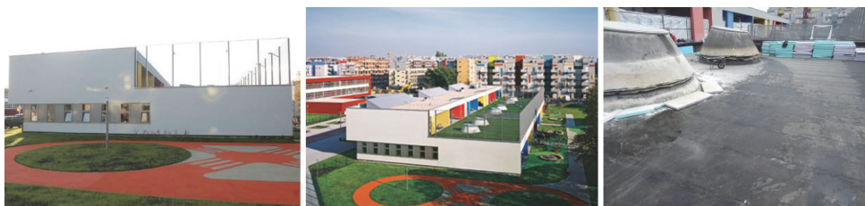
Slika 8. Fotografije zelenog ravnog krova promatranog dječjeg vrtića, prije i tijekom sanacije
