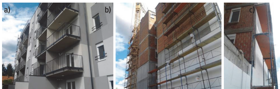
Slika 11. Stanje višestambene zgrade na dan energetskog pregleda
