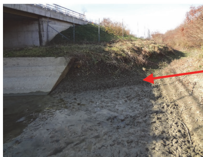
Slika 1. Urušavanje obale kao posljedica nagle promjene geometrije kanala (lijevo); uzdužni profil brzine s naznačenim povećanjem brzine na mjestu urušavanje obale (desno)
