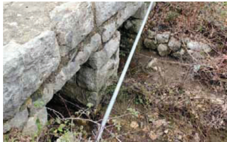
Cestovni propust (Pc5)
