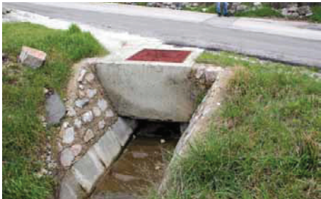
Cestovni propust (pc4)
