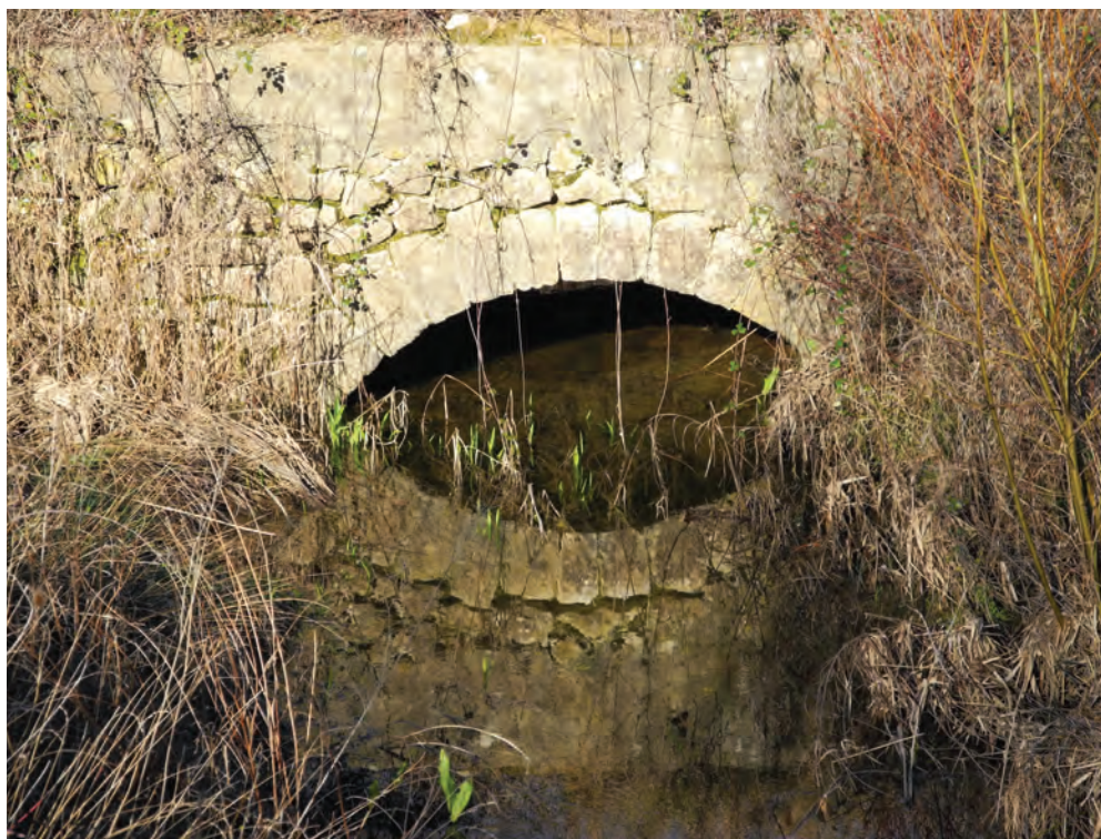
Slika 6. Mostić na potoku Mostina
