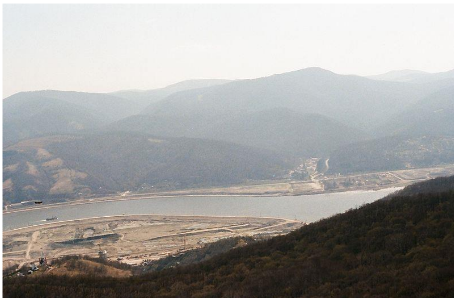
Slika 14 Pogled na građevnu jamu u Dunavu prije restauracije [9]
